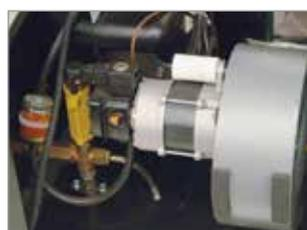
MOTORE BRUCIATORE MONOFASE ACCOPPIATO CON POMPA GASOLIO E VENTILATORE.
